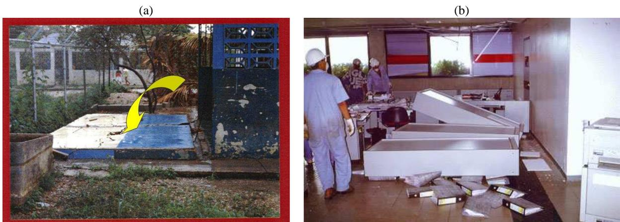
**Figura 11.** (a) Volcamiento de paredes y (b) volcamiento de mobiliario (MIDAS, 1997) durante el sismo de Cariaco de 1997.
